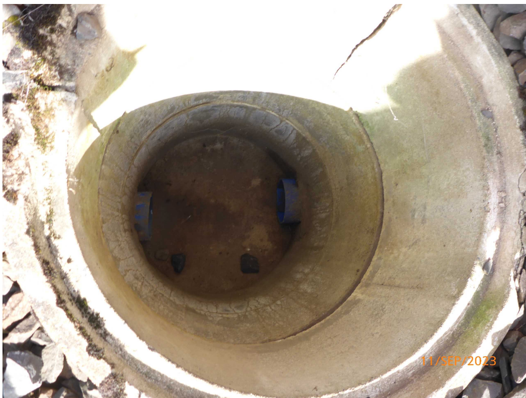
Bild 9: Schacht TE trocken, Schachtring gerissen km 15,140
