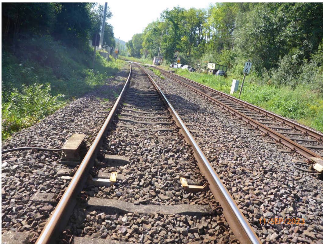
Bild 33: Kabelquerung im Fach, Indusi, ÜS km 11,619
